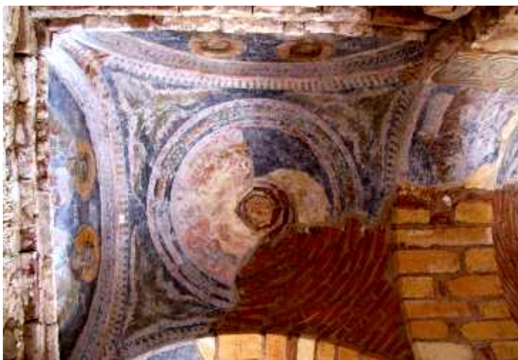
Dipinti su muratura in laterizi
